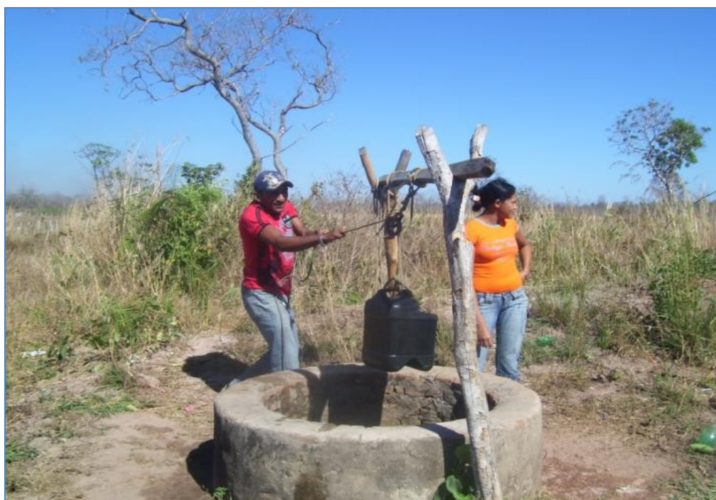
Ilustração 2 – Poço cacimbão, bastante utilizado nas localidades em que não há rio ou córregos
