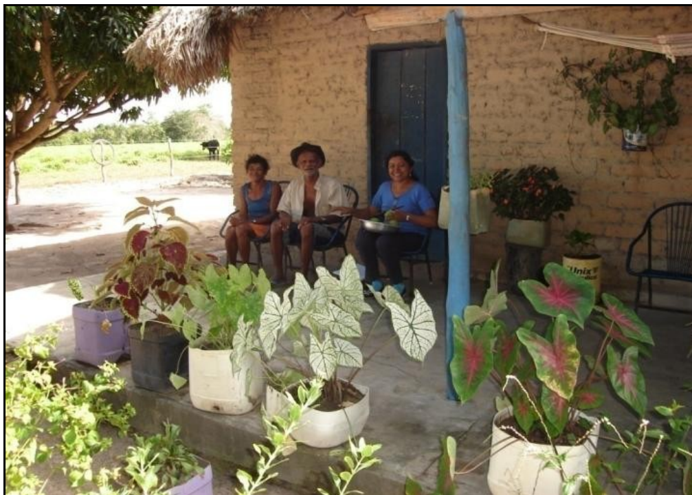
Ilustração 23 – Casa de adobe e cobertura de palha de piaçava, típica da zona rural (região do Correio).
